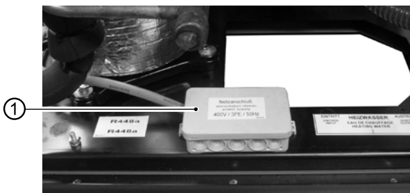
1 Elektrická připojovací skříňka: Síťová přípojka tepelného čerpadla
