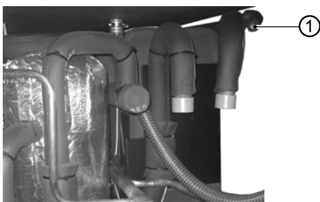
1 Odvzdušňovací ventil nad hydraulickými přípojkami v jednotce
